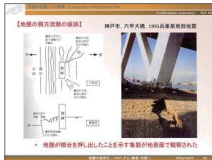
六甲大橋の橋脚付近の亀裂の様子は、被害のメカニズムを教えてください。海側に押し出す方向に流動化した地盤が変位したために橋脚には大きな水平力が作用し、これが原因で橋脚が水平に変位して橋桁が落下したと考えられています。
