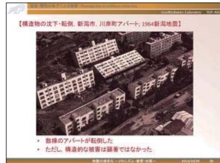
新潟地震で被害を受けた川岸町のアパート群です。教科書等でもしばしば紹介されているものです。アパートが大きく沈下したり、転倒しています。
