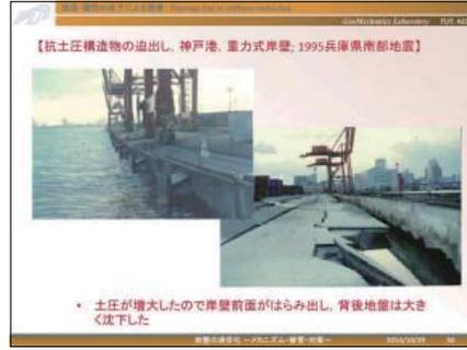
阪神淡路大震災で被災したポートアイランドの岸壁です。岸壁は大きく迫り出し、背後の地盤は沈下しました。荷役用のクレーンが載っているレール(杭に支持されている)がきわどく残っています。
