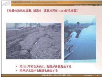
信濃川河岸の側方流動の様子です。液状化した地盤には河岸に平行な亀裂が複数走り、河川に向かって流動化していることが分かります。
