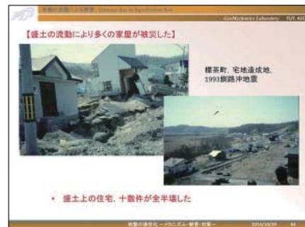
釧路沖地震では、標茶町で開発された住宅地でも液状化による被害が発生しました。住宅盛土が崩壊し複数の住宅が大破しました。
