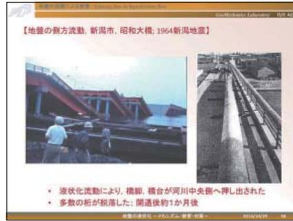
新潟地震における信濃川に架かった昭和大橋も大きく被災しました。新潟市は地震の10年ほど前の大火で失った市街地の復興のため、予算を投じて社会基盤の整備を行っていましたが、昭和大橋もその一つで地震発生のおよそ1か月前に完成しました。架橋地点では、河床も含めて地盤が液状化し側方に流動したため、杭基礎を採用した橋脚は側方に変位しました。これにより、複数の橋桁が落下しました。現在ではこのような形式の橋脚は使われなくなっています。
