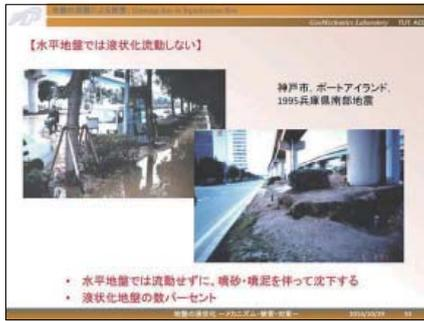
阪神淡路大震災後におけるポートアイランドの様子です。地盤が比較的平らな場合には地盤沈下を明瞭に観察することができます。液状化した地盤では、液状化した層厚の数パーセントが沈下量として観察されます。地下水が浅い場合には沈下量に相当する泥水が噴出してきます。杭基礎の近くでは大きな段差が見られます。
