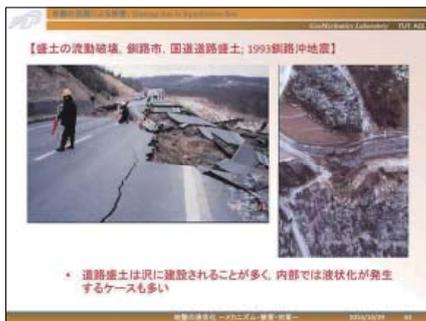
釧路沖地震では種々の盛土が被害を受けました。前後を切土して沢地に建設された道路盛土では、地下水が盛土内に浸潤するので、盛土自体が液状化することがあります。液状化した地盤は斜面を流下しました。
