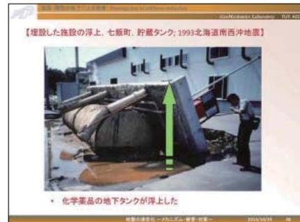
これは北海道南西沖地震で見られた液状化による埋設物の被害です。工場脇の薬品貯蔵タンクが地震時にはほぼ空であったため、液状化した地盤からの浮力で浮き上がってしまいました。
