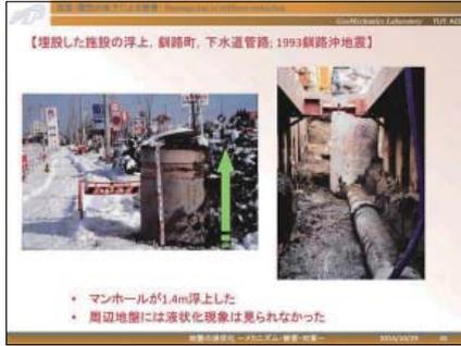
釧路沖地震において被災した釧路町の下水道、マンホールです。マンホールは1.4mも浮上したので、見たときは驚きました。これも液状化した地盤の浮力により浮上したものです。
