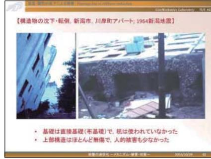
同じく、新潟地震で被災した新潟市川岸町のアパート群です。アパートの底が見えてしまうほど大きく転倒しました。液化化現象がまだ自然災害として意識されていなかった当時としては、砂地盤は粘性土地盤に比べると常時においては安定で比較的良好地盤として認識されていたので、杭基礎は用いられていませんでした。しかし、一旦液化化すると、このようなことが起きるのです。もう一つ注目すべきは、これだけの被害が発生したにも関わらず、上部工への被害は軽微で転倒後にも窓が開いたようです。負傷者も少なかったようです。これは、液化化しが地盤が制振装置として作用したことを教えてくれます。
