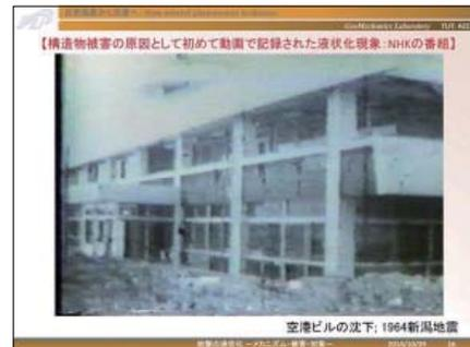
1964年新潟地震の際に新潟空港に居合わせたカメラマンの弓納氏によって撮影された動画です。近代的な施設を襲った地盤の液状化現象の深刻さと重要性を、初めて広く知らしめている。地盤地震工学における第一級に貴重な資料です。地震の発生とともに、滑走路のエプロンには吹き出した泥水が流れ出して一面を覆った。空港ビルは、液状化して支持力を失った1m以上も地盤へ沈み込んでいきました。
