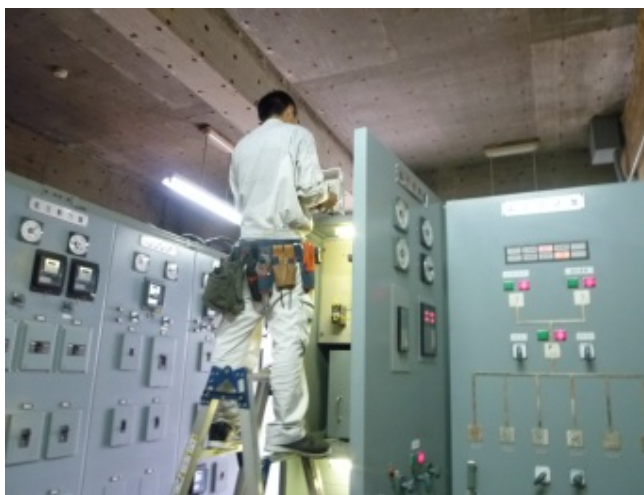
写真-3.6.3 非常時のエネルギー需給計画の検討 に向けた電力使用量の測定
